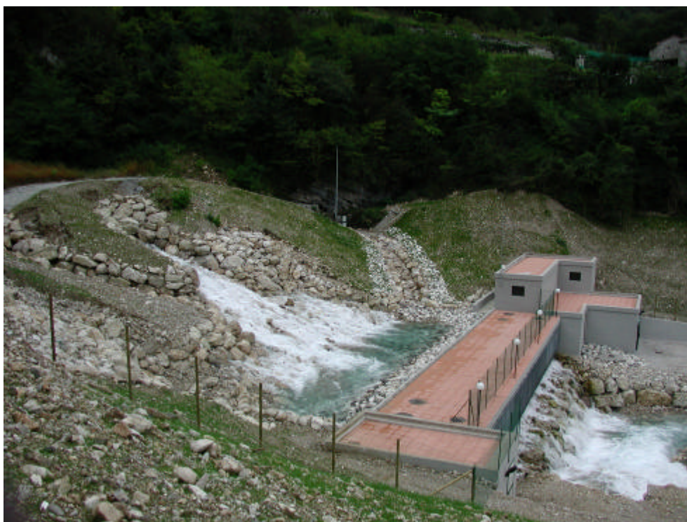
Fig. 3.9 – Opera di captazione (2002) della sorgente Fium a Vas
